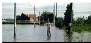
【平成8年】中橋付近浸水状況
