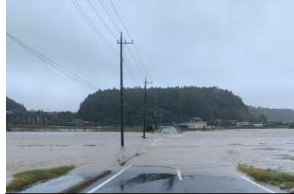
【令和元年】山武市矢部付近浸水状況
