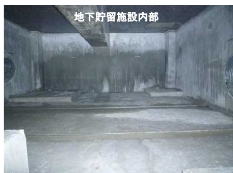
雨水貯留浸透施設の事例【横浜市内】
