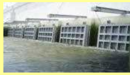
排水ポンプ車による緊急排水
