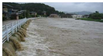
【平成27年】平久里川横峯大橋付近浸水状況
