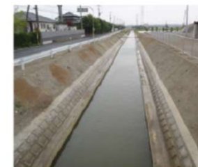
排水路の整備
