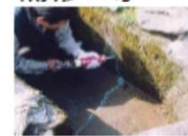
水路のひび割れ補修
