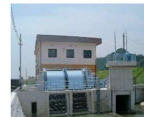
排水機場の整備
