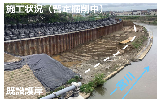
写真② 河道改修 (護岸法立て)
