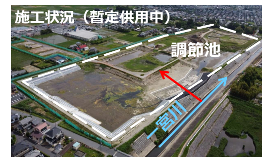
写真③ 一宮川第二調節池の増設
