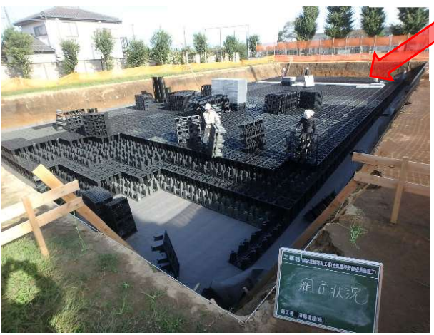
貯留浸透施設設置状況
