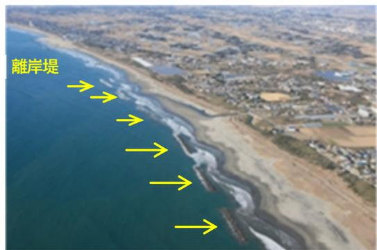
離岸堤: 沖合に、海岸線と平行に消波ブロックを積み上げた構造物のこと。沖合からくる波を弱めて、離岸堤の背後に砂を堆積させ、侵食を防止する。
