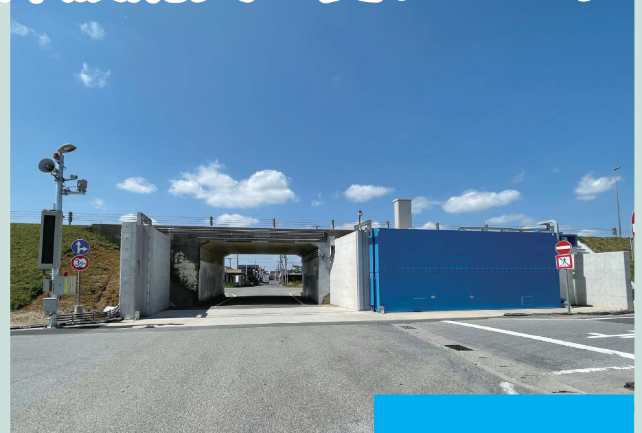
10号陸間（九十九里有料道路・不動堂IC付近）
