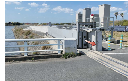
真亀橋(九十九里町)
