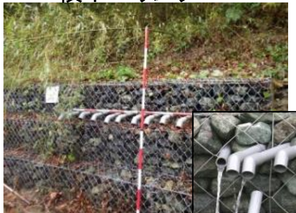
横ボーリング工
