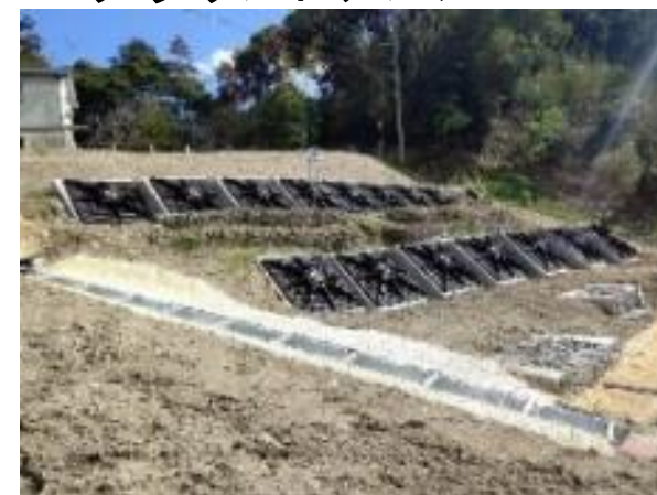
グラウンドアンカー工
