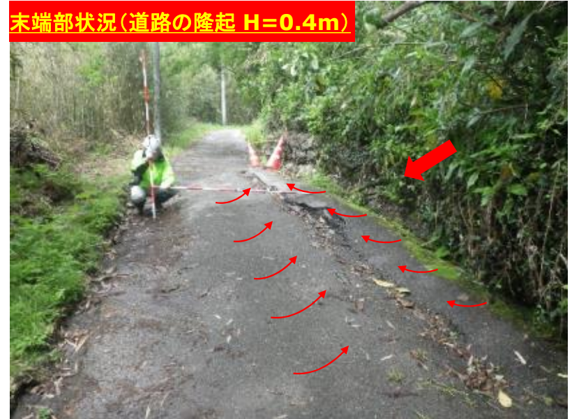
末端部状況(フンカゴの押出し)
