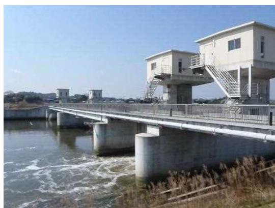
■ 現在の松潟堰の様子
