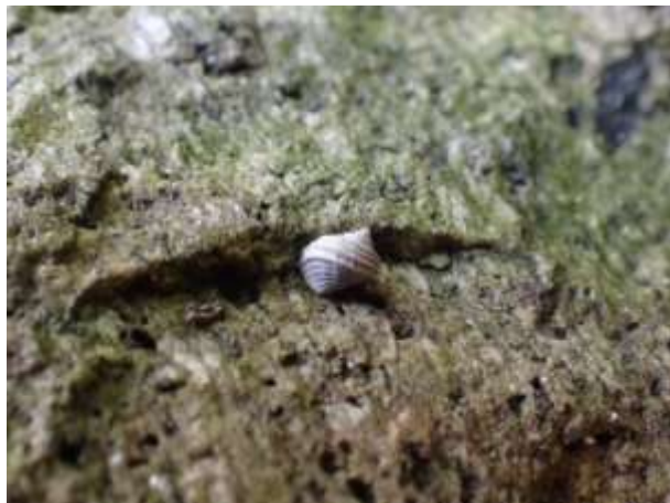
高潮帯付近の石積み表面で確認されたタマキビガイ
