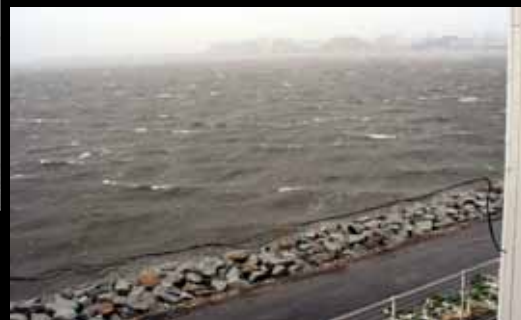
1工区(捨石部)前面 撮影：平成19年9月7日6時48分
