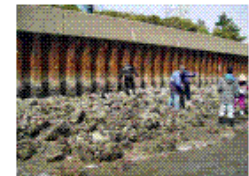
直立護岸と直下の状況
