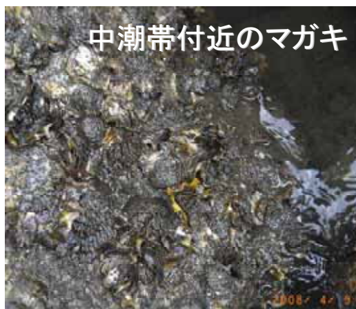
(2 工区中潮帯:施工後約 8 ヶ月)
