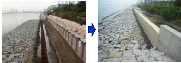
上部工(H鋼杭+鋼矢板:100m)
