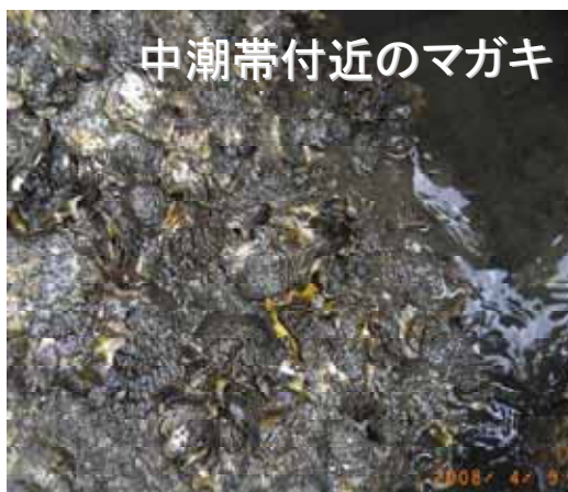
(2 工区中潮帯:施工後約 8 ヶ月)
