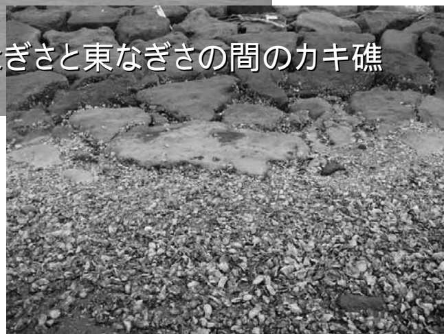
写真-3.4.9 石積み部周辺の状況(葛西海浜公園)
