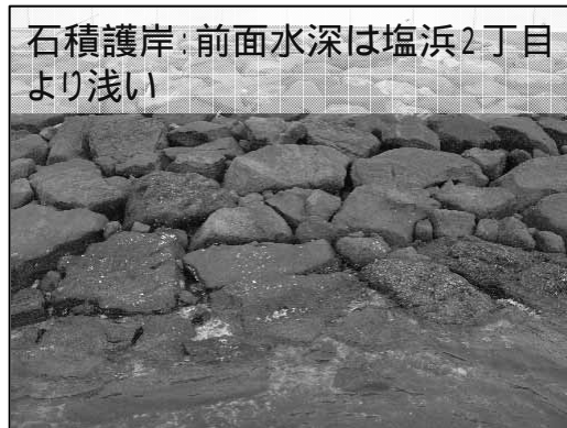
写真-3.4.7 突堤及び石積み護岸周辺の状況(幕張の浜)
