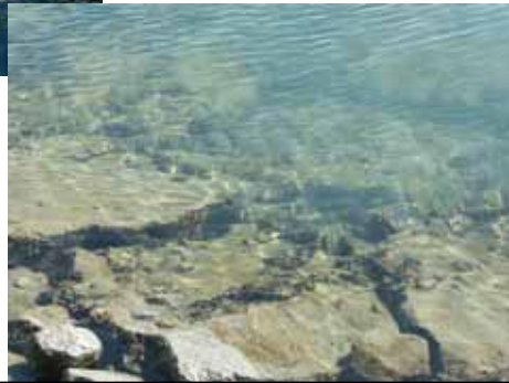
1工区石積み護岸のり先の状況
