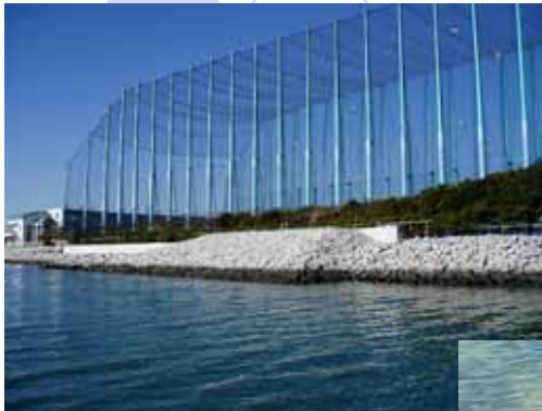
1工区石積み護岸の状況
