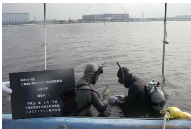
ダイバーによる計器点検（平成20年6月17日：ST1）
