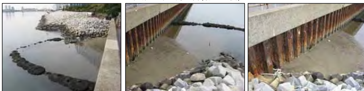
平成 21 年 11 月 16 日 (施工後約 4 ヶ月)
