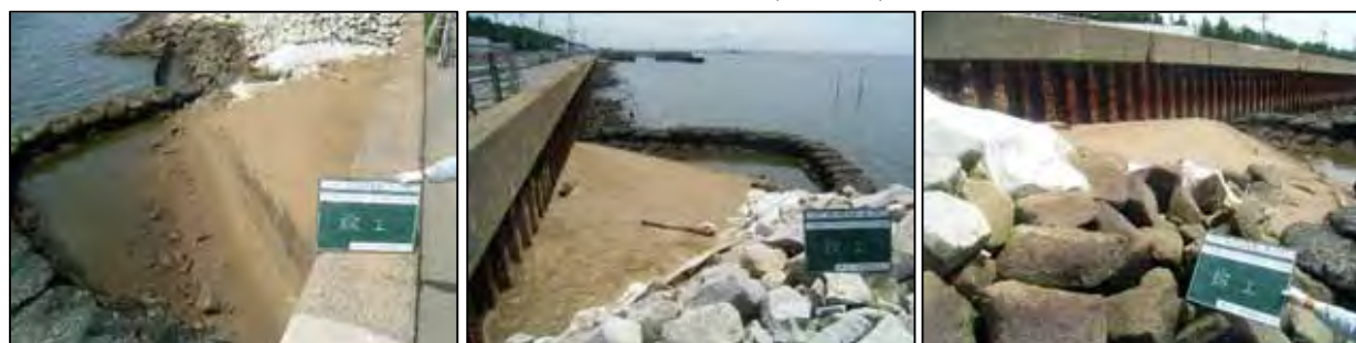
平成 21 年 7 月 7 日 (施工直後)
