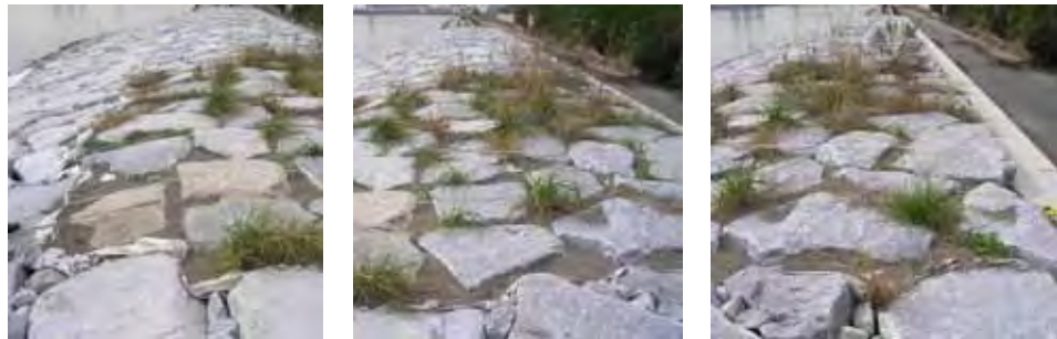
購入砂ゾーン（左が海側）第 14 回モニタリング調査時
