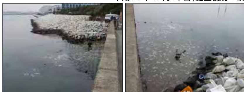
平成 22 年 1 月 12 日 (施工後約 6 ヶ月)
