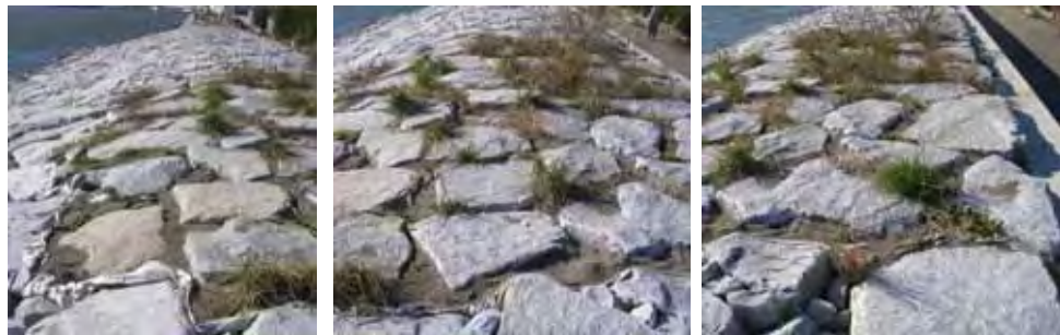
購入砂ゾーン（左が海側）第 15 回モニタリング調査時
