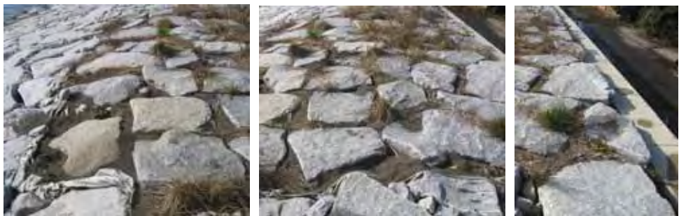
購入砂ゾーン（左が海側）第 16 回モニタリング調査時
