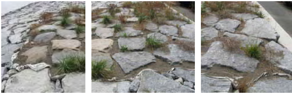
購入砂ゾーン（左が海側）第 13 回モニタリング調査時
