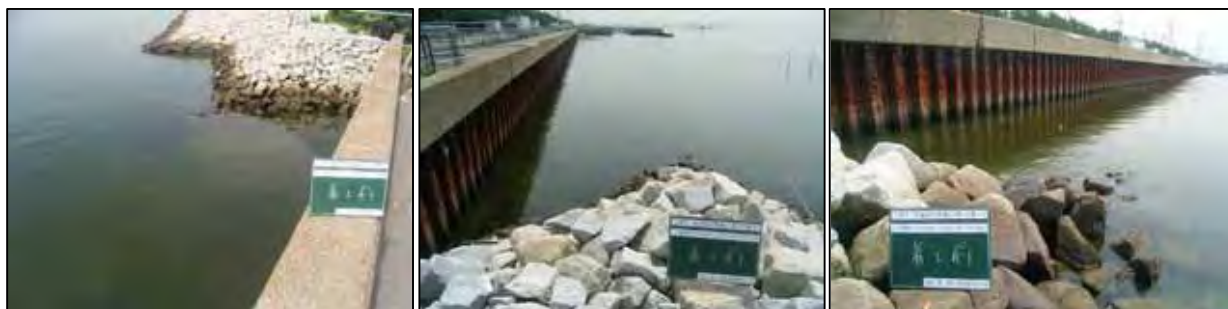
平成 21 年 6 月 12 日 (施工前)
