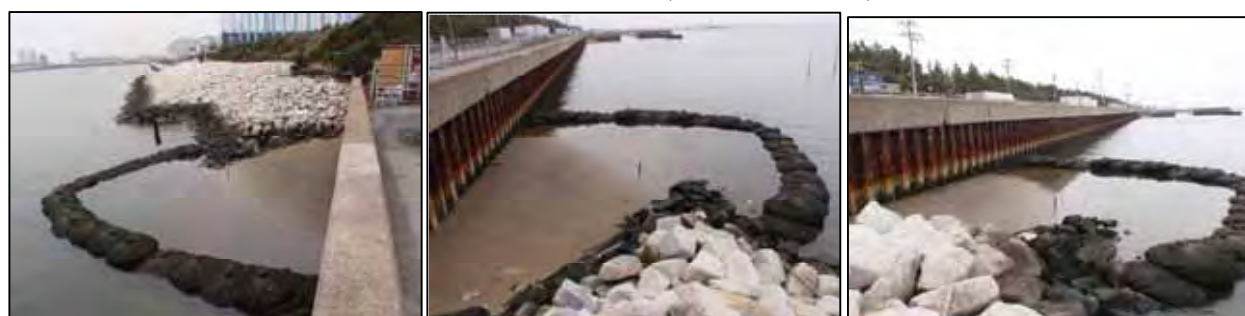
平成 22 年 2 月 16 日 (施工後約 7 ヶ月)
