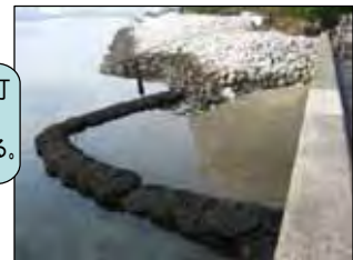
H21年10月14日 (施工後約3ヵ月) 撮影時潮位A.P.+0.6m程度
