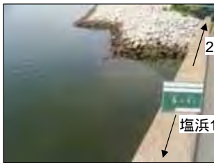
H21年6月12日 (施工前)
