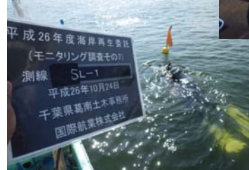
水面下での調査状況
