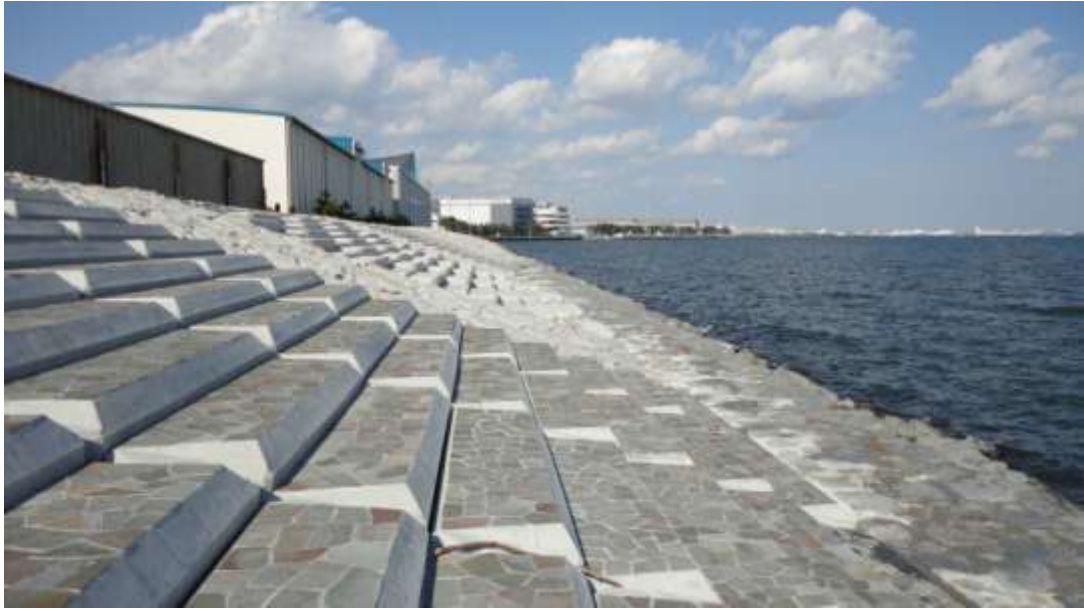
市川市塩浜2丁目護岸（階段式バリエーション部分） （前方は市川市塩浜1丁目）
