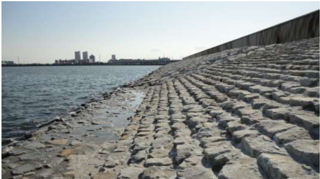
市川市塩浜2丁目護岸（階段式バリエーション部分） （前方は市川市塩浜3丁目から浦安市）
