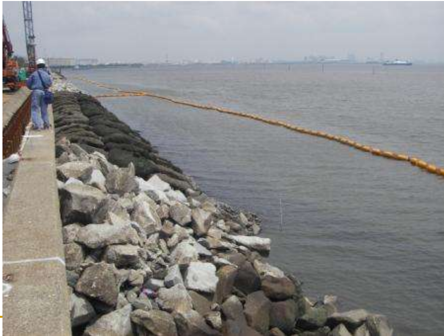
石積護岸部（捨石工）周辺の状況 (H24年5月21日)
