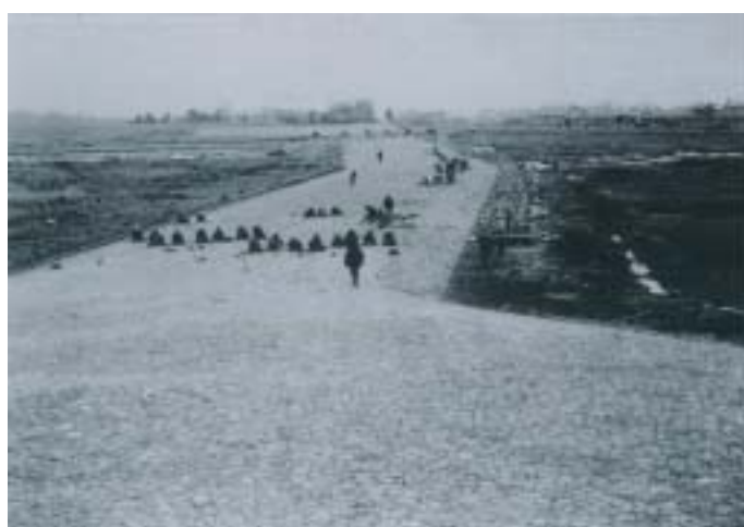
図 1-1-7 江戸川放水路の開削
