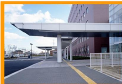
段差がなく、見通しのよいアプローチ通路 視覚障害者誘導用ブロックの敷設
