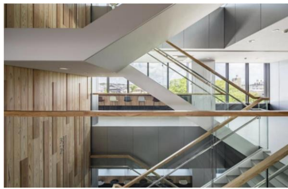
《山武地域産材を使用した内装木質化》 （千葉県山武合同庁舎）
