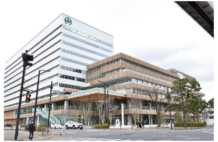
千葉市庁舎 ZEB Ready 延床面積：49,400 m 2 階数：地上11階 竣工年：2023年
