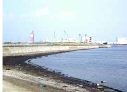
図 2 - 5 - 8 船橋市潮見町
