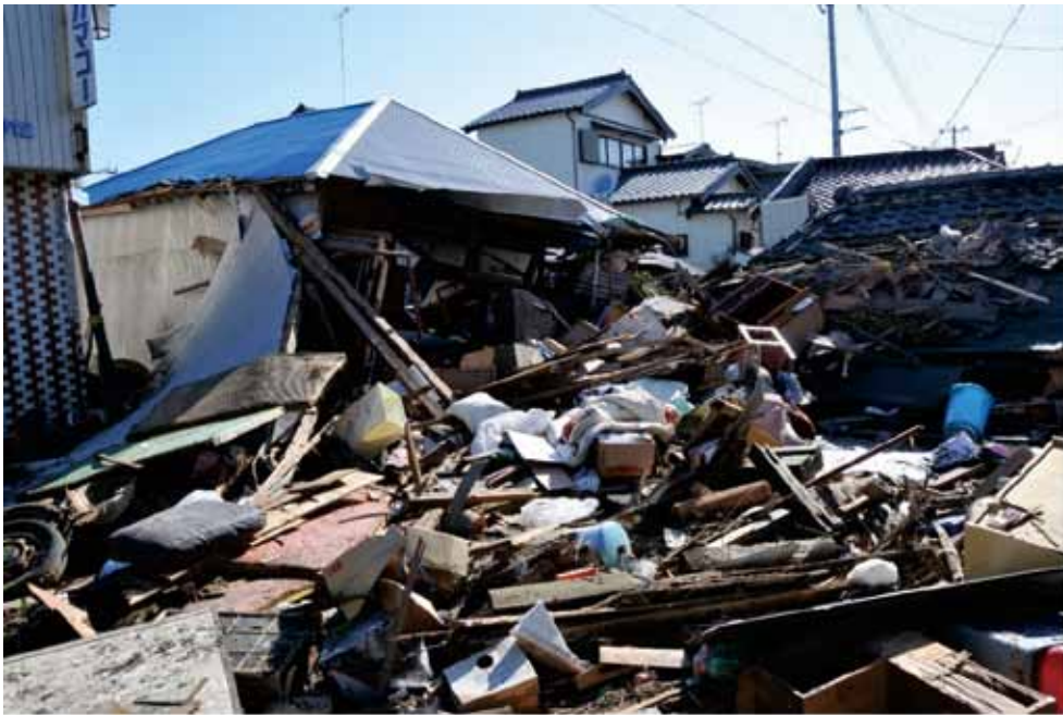
平成23年3月 東日本大震災（発災直後に撮影） 津波被害状況（飯岡地域） 《提供：旭市》
