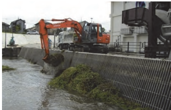
取水口をふさぐ外来水生植物の駆除状況
