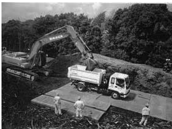
不法堆積された木材チップの除去
