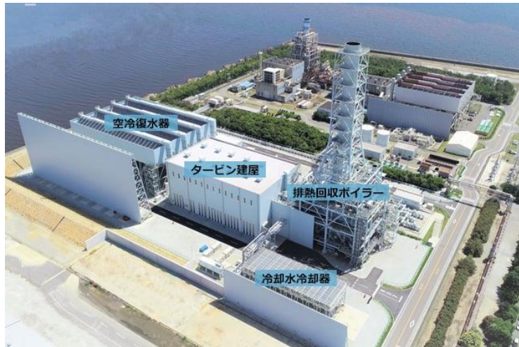
(出典) 三菱パワー株式会社ホームページ 発電所の写真
