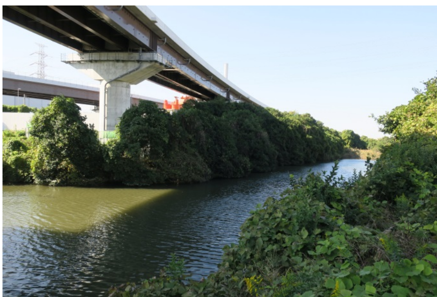
写真2 高谷川左岸から見た高谷ジャンクション下の河畔林
