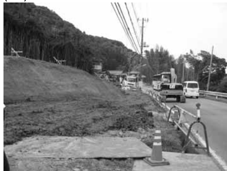
(12)道路新設改良負担金
