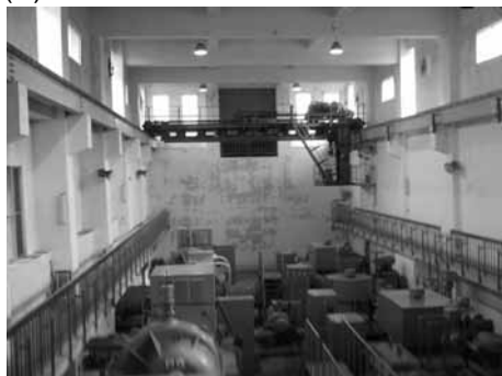
(9)一之分目揚排水機場管理費負担金
