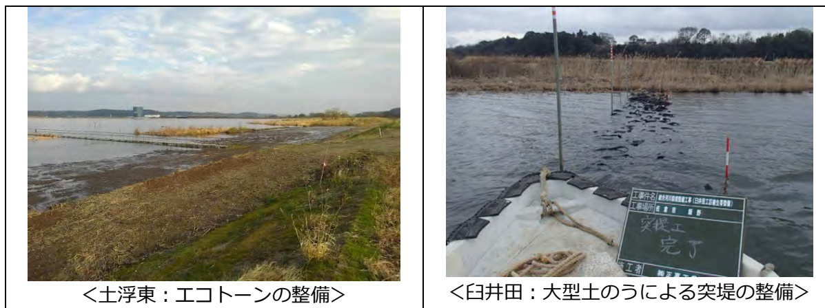
図 6.31 浚渫土を活用した植生帯の整備
