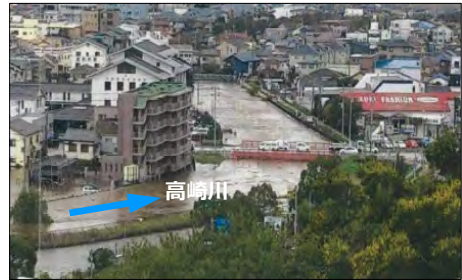
▲H25年台風26号出水状況（高崎川）
