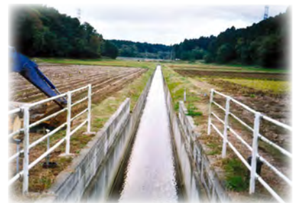
コンクリート化された水路
