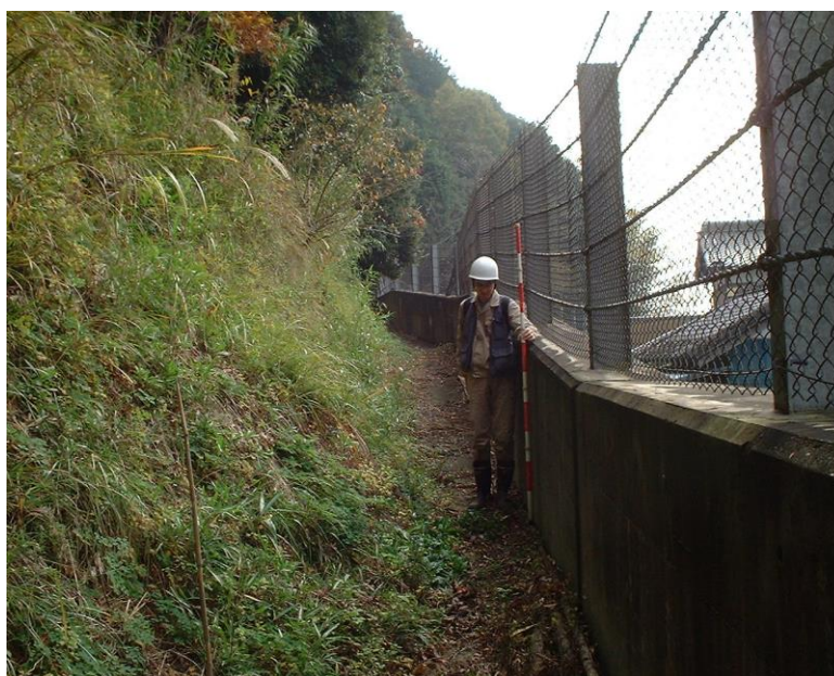
写真 5.2 待受対策施設ポケット状況
