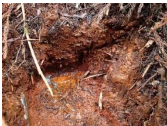
図 4.5-4 地滑り地塊の地質状況の確認状況（地滑り区域内で確認）
