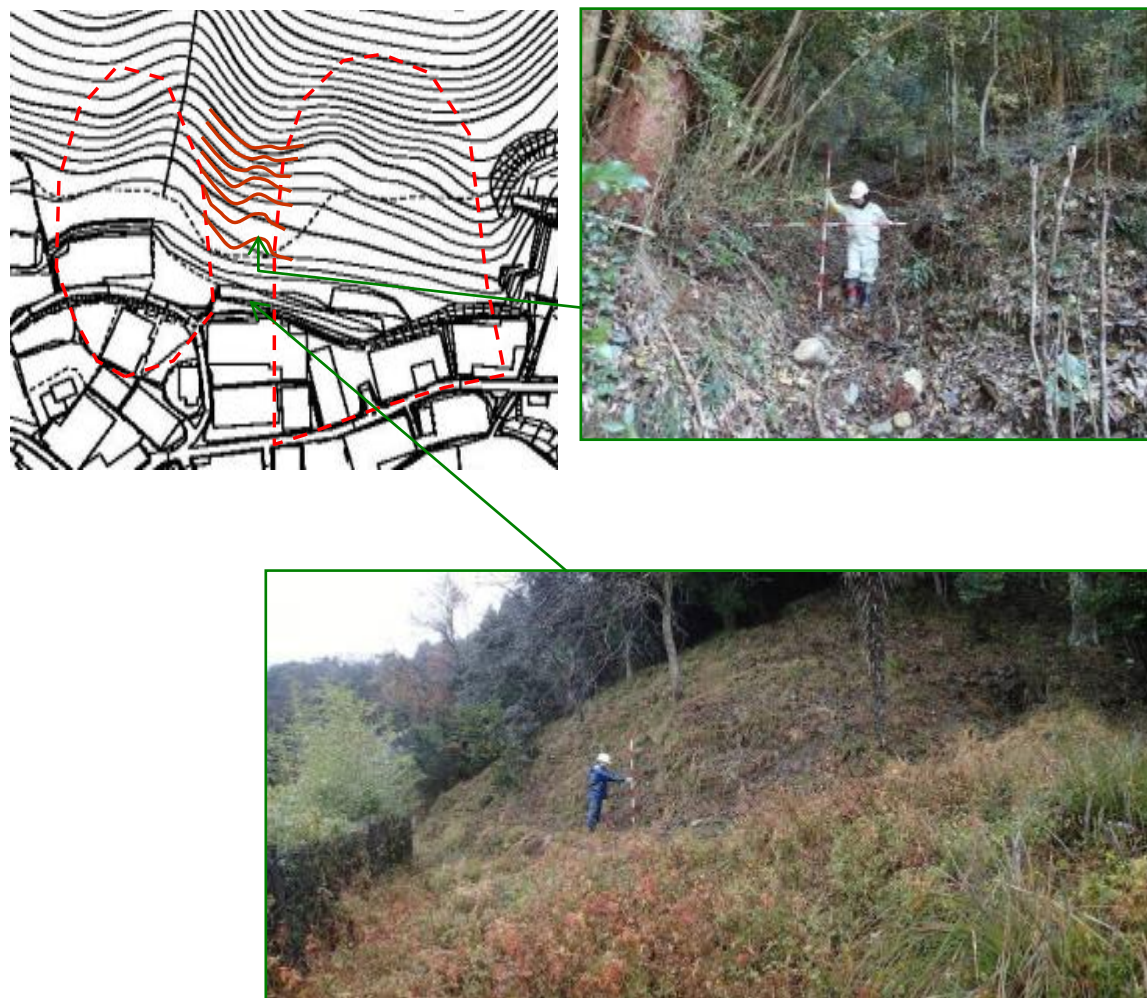
図 4.5-7 基盤図で表現されていない微地形の確認事例
