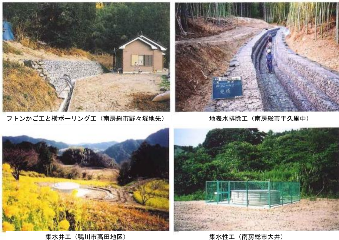
図 4.1-2 千葉県での地すべり対策例
