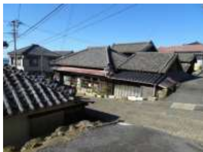
写真 6-5 銚子市外川漁港の町並み
