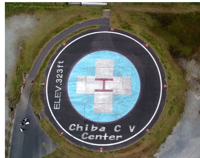
上空から見た循環器病センターのヘリポート
