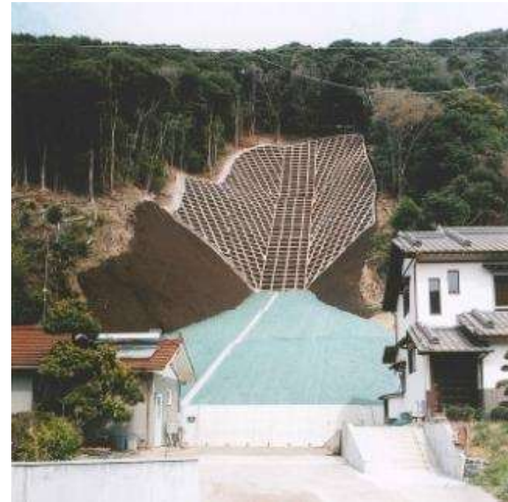
予防治山工事（山腹工）
