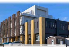
東部家畜保健衛生所 (令和7年度新設)
