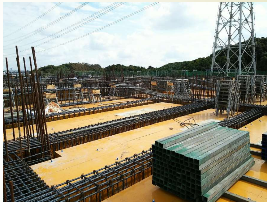
配筋工事状況
