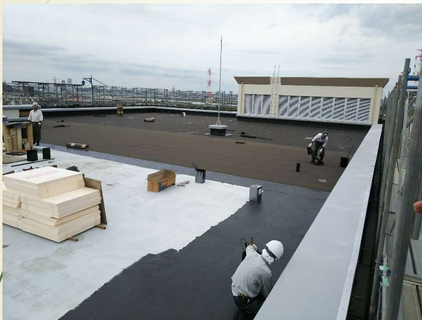
防水工事状況
