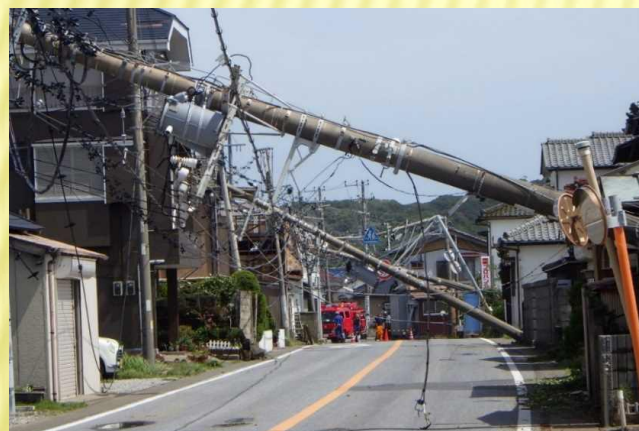
令和元年房総半島台風による影響(館山市) 電柱倒壊により道路が封鎖
