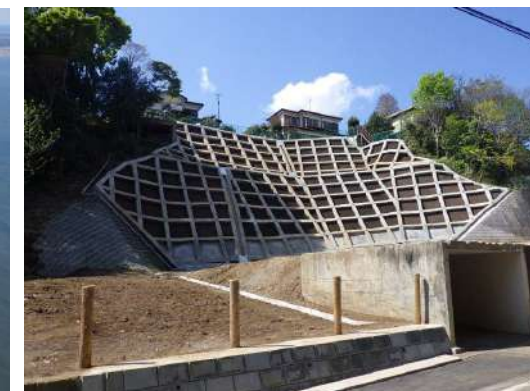
法枠工（千葉市）
