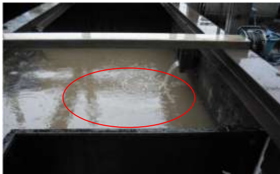
側溝からの雨水が油水分離槽に入るところ 油膜が見える
