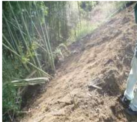
崖下部分の汚泥を撤去した状態
