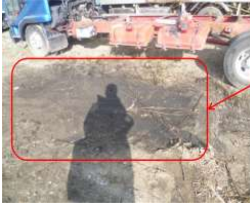
自動車置場部分で黒い染みが残っていたため、撤去するよう指示した箇所
