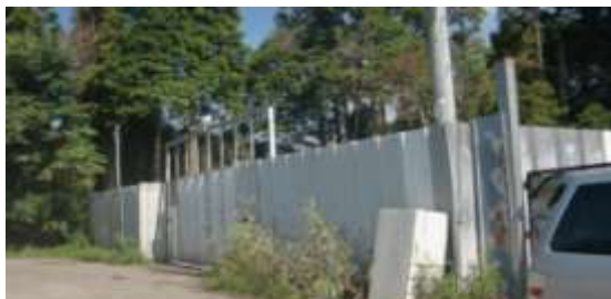
矢板を使用しているヤード
