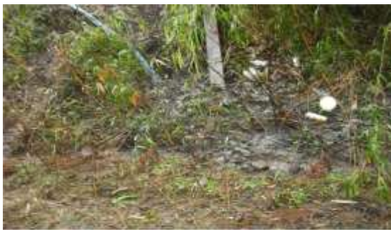
ホースの先 油泥が付着している
