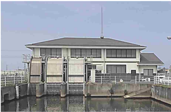
ポンプ場の整備
