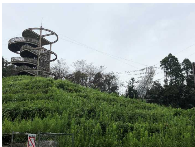
君津市かずさ小糸（鉄塔倒壊）
