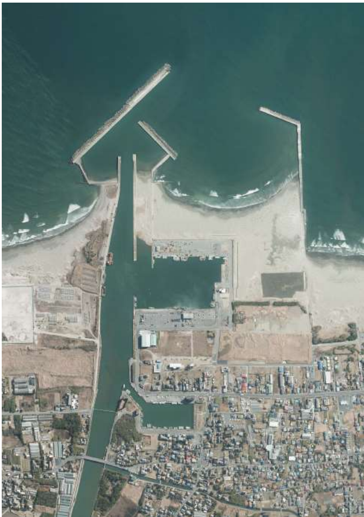
片貝漁港航空写真 平成 27 年 1 月撮影
